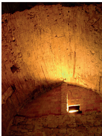
Fig. 66. Detall de la volta apuntada de la planta baixa de la torre.
