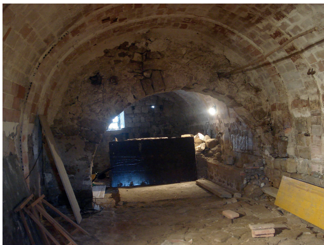
Fig. 81. Arc de creugia de la planta inferior del cos d'edifici de ponent de Torre Desvern.
