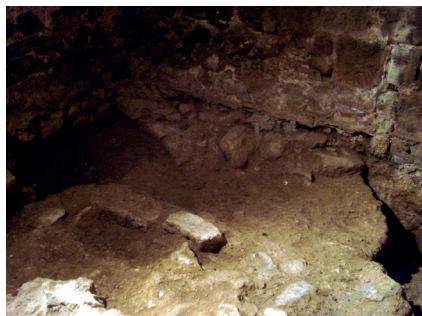
Fig. 53. Vista de l'est de l'àmbit 23, on ja s'observa el mur M-98.
