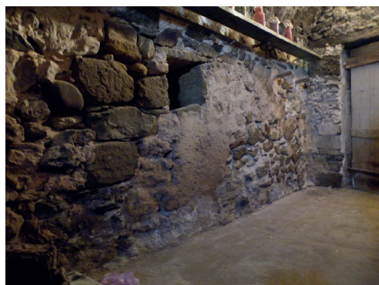
Fig. 79. Vista de l'arcada al sud-oest del pati, que avui es conserva paredat.
