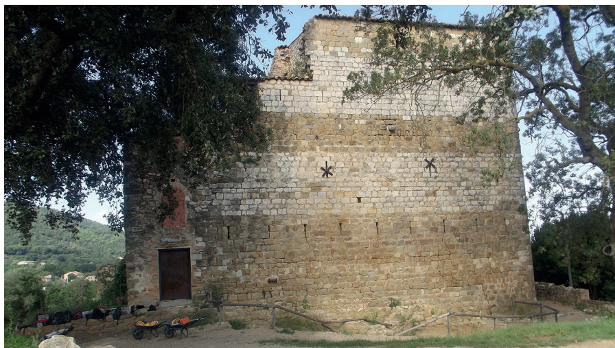
Fig. 65. Façana est de la torre. S'observa un petit tram del mur obrat en espina de peix sobre la banqueta de fonamentació.
