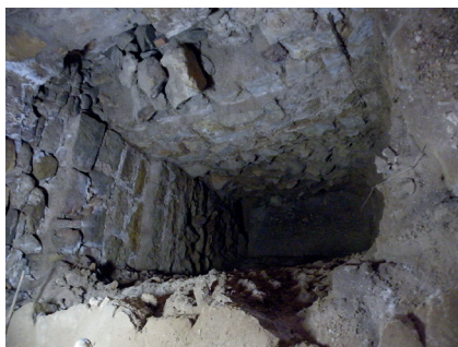
Fig. 64. Aspecte de la cala que uns afeccionats locals van obrir a l'angle interior format per la intersecció del mur perimetral sud i el mur de tanca oest del pati. S'observa la potent fonamentació.
