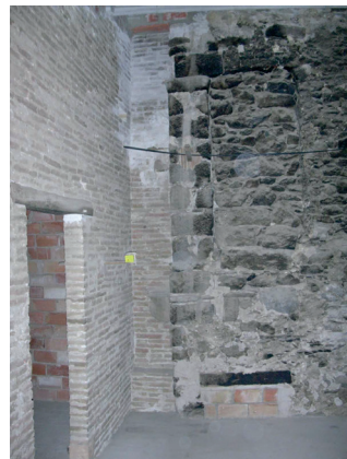
Fig. 96. Pilar cantoner de l'antic badiu. Avui es conserva integrat en un mur.
