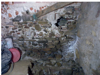
Fig. 80. Arrencament de l'arc de migdia de la paret oest del pati.
