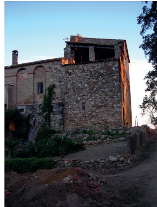
Fig. 107. Vista de la part oriental de la façana sud de l'edifici on s'observa l'escassa qualitat de la paret moderna amb què referen la torre.
