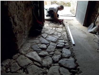
Fig. 43. Àmbit 22. El paviment de formigó s'assentava damunt l'empedrat del segle XVIII.
