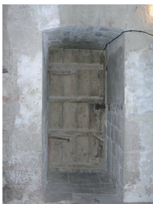
Fig. 77. Interior de la porta de la sala de la torre.
