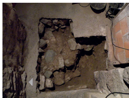
Fig. 47. Cala efectuada a l'àmbit 23 (2016).
