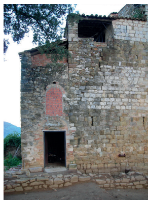
Fig. 105. Vista del tram meridional de la façana est de la torre. S'observa la diferència entre el parament medieval i la refecció moderna.
