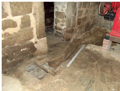
Fig. 36. Enllosat (UE 4002), canalització (UE 4004) i fossa sèptica (UE 4006).
