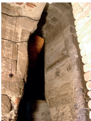
Fig. 104. Imatge on s'observa com els brancals de la porta que comunica el nord de la zona 2 amb la zona 4 queden penjats a un nivell força més alt respecte al nivell de circulació actual.
