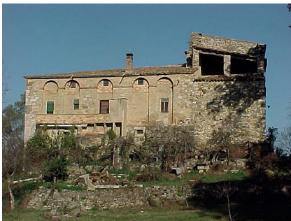
Fig. 110. Vista general de la façana sud de l'edifici, on s'observen els nombrosos canvis i refeccions que sofrí aquesta part. Entre altres elements, es poden veure les arcades cegues de la falsa galeria.
