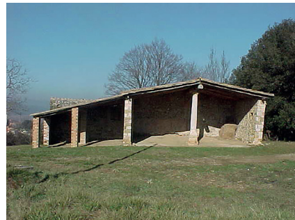
Fig. 111. Vista general de l'era, situada pocs metres al nord-est de l'edifici.
